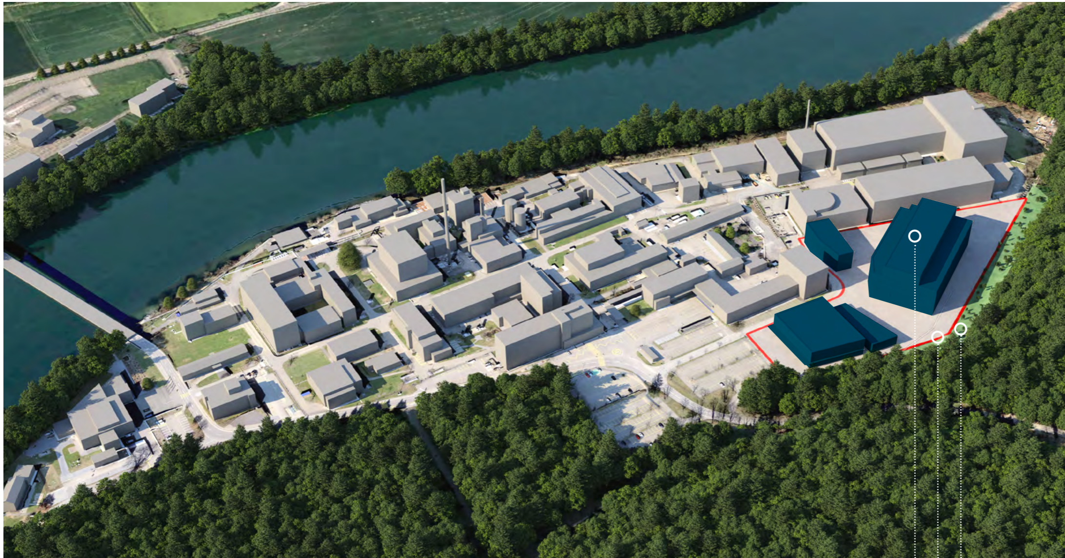
Die Brennelementverpackungsanlage wird auf dem Areal des Zwiilag gebaut.
