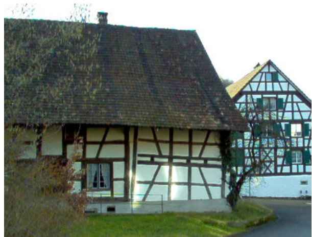
Der rechte Hausteil ist jünger als der linke. Sicht von der Oberdorfstrasse Richtung Südwesten
